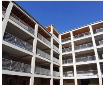
Hier noch in der Bauphase: Der Grazer Arkadengarten. Arkadengarten
