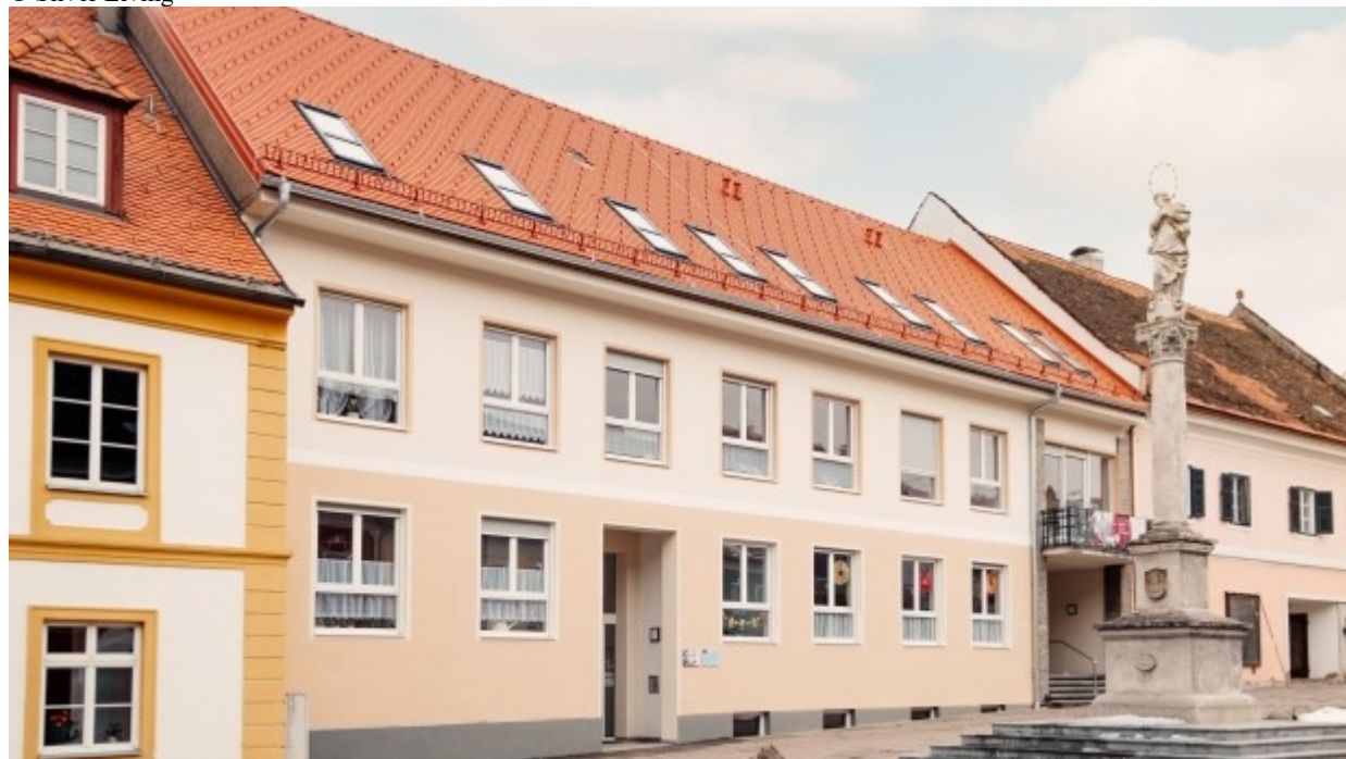
Die Wohnanlage in Obdach
