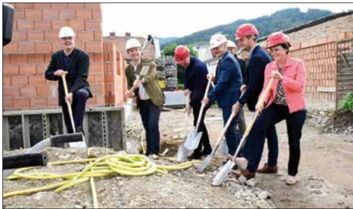
Spatenstich für das Generationenhaus in Kindberg. Wo heute noch Baustelle ist, werden im Herbst schon Kinder spielen.
