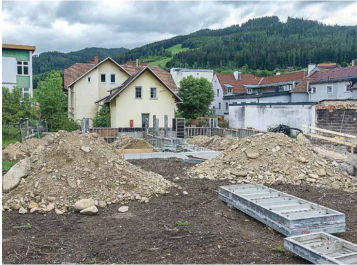
Im Mai erfolgte der Baustart für die neue Kindberger Kinderkrippe.
