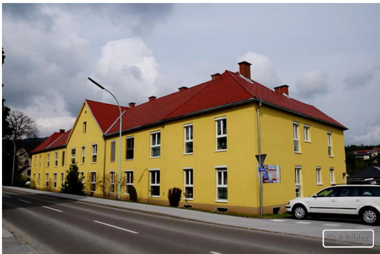
Das Haus in der Dr. Niederdorferstraße wurde komplett renoviert.
