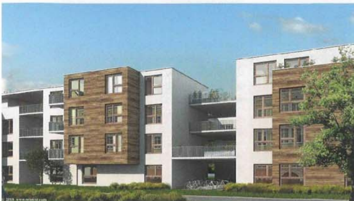
60 Wohnmodule in Holzbauweise ergeben ein Studentendorf
