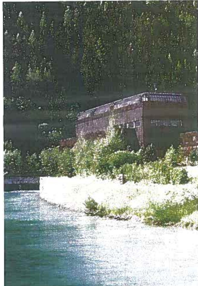
Die Bundesforste nutzen ihre zahlreichen Gewässer mit Kleinwasserkraftwerken für die Stromproduktion
