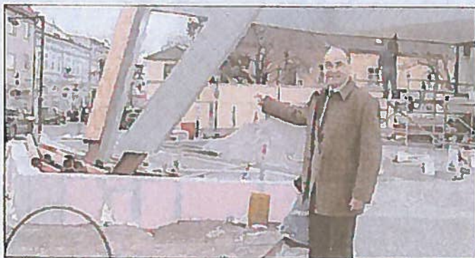
Bürgermeister Andreas Linhart überzeugt sich vom Fortschritt der Arbeiten rund um das Ortszentrum. Hier entsteht der Brunnen. Foto: Schätzle
