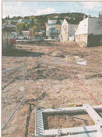
Die Bauarbeiten für die Mödliner Seniorenresidenz sind gestartet.
